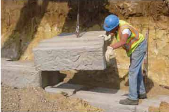
Plassering av blokk ved hjelp av løfteanker
